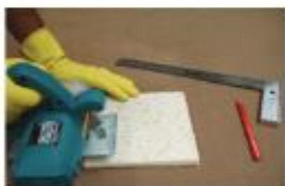
Corte das peças com serra elétrica manual e conferência do nivelamento
